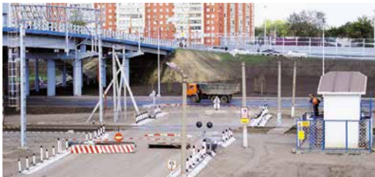
Путепровод на ул. 15-я Рабочая
