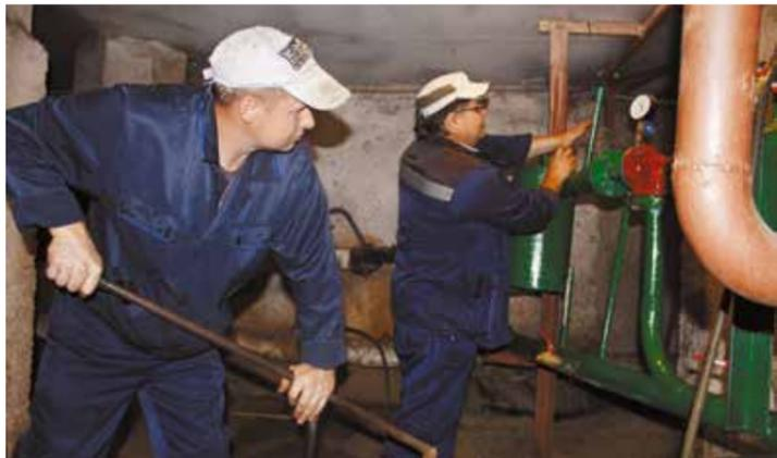
Опрессовка тепловых систем в ЗАО «Сибирский коммунальник»
