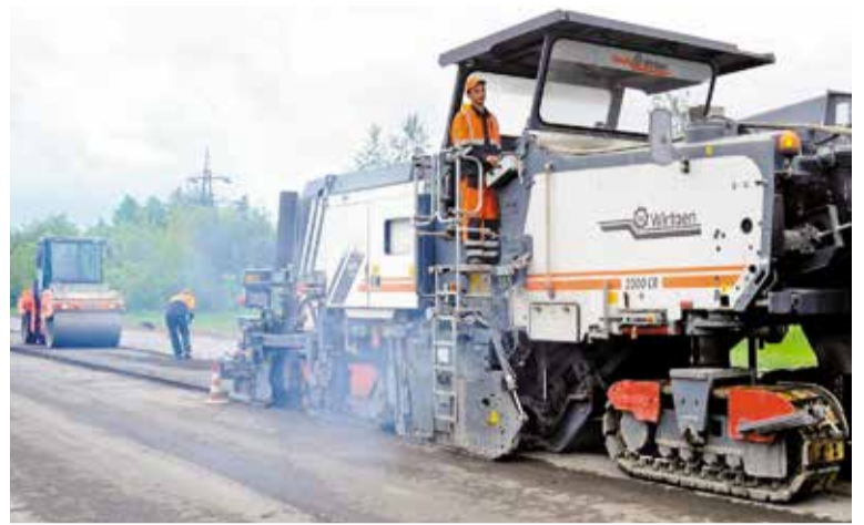
Дороги ремонтируют современной техникой
