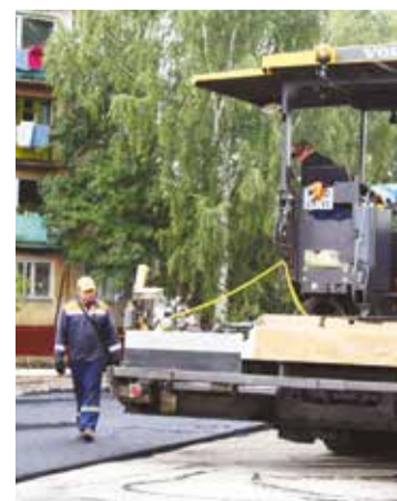
В этом году в округе заасфальтировано 79 дорожных объектов
