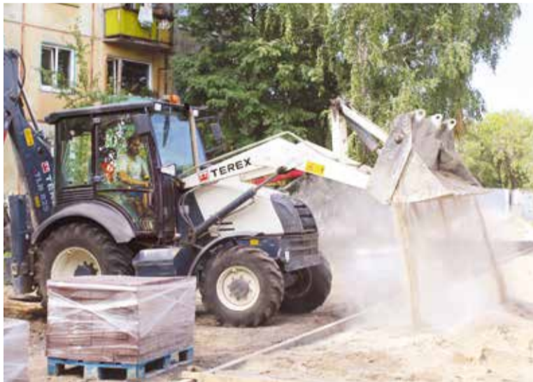
Обустройство пешеходных дорожек в сквере «Крылатое братство»
