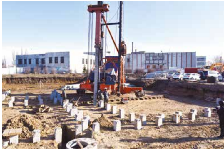
Начальный этап строительства детского сада в Октябрьском округе
