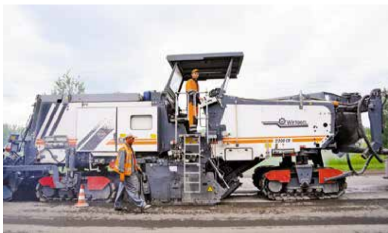
В Омске продолжается ремонт дорог по нацпроекту
