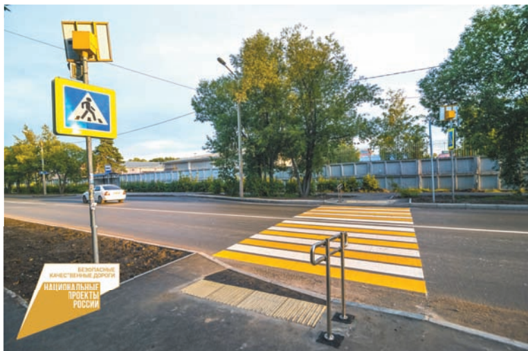
Улицу 5-ю Кордную отремонтировали по нацпроекту «Безопасные качественные дороги»
