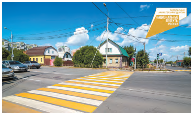
Отремонтированный участок улицы Шебалдина
