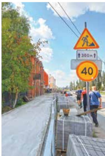
Работы на ул. Лермонтова
