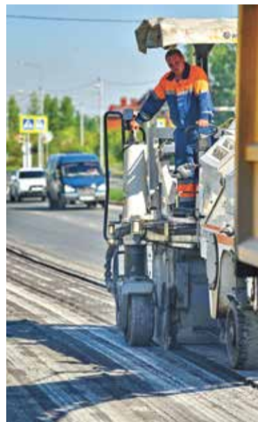
Самым масштабным проектом 2020 года стало строительство дороги-дублера на Левобережье
