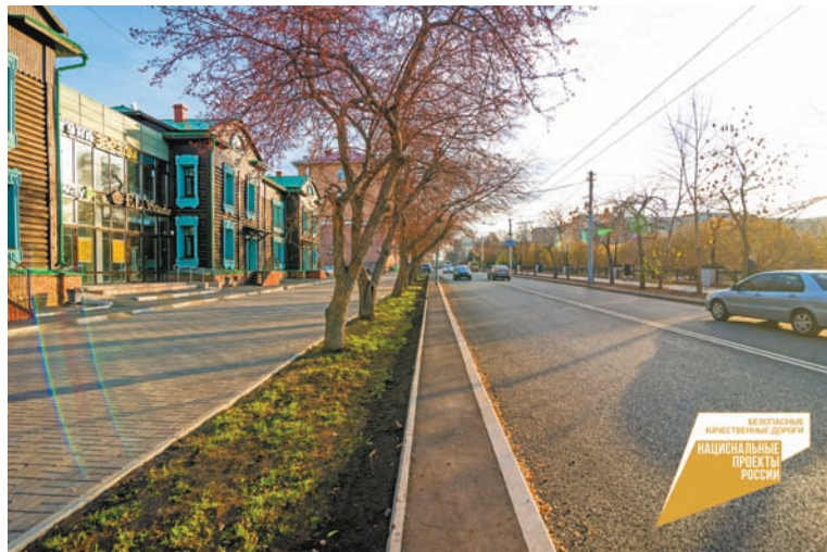
В 2021 году была отремонтирована ул. Маяковского
