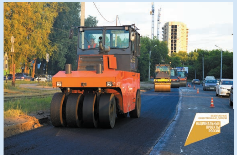
Комплексный ремонт улицы Маршала Жукова
