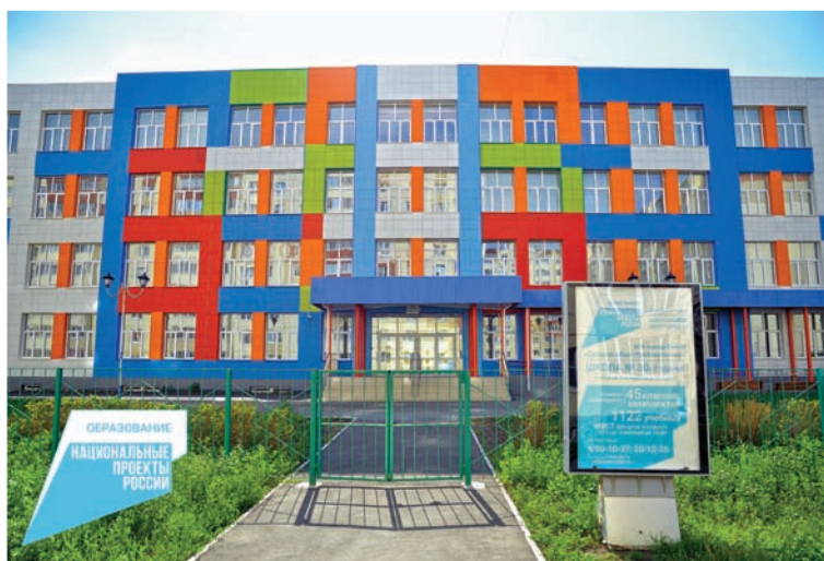
В этом году начала работать школа в микрорайоне Амурский-2
