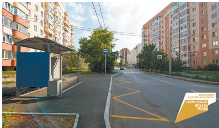
Дороги ремонтируются комплексно – с обустройством остановочных комплексов, тротуаров и ливневой канализации, установкой светофоров и дорожных знаков
