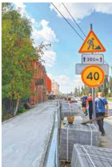
Работы на ул. Лермонтова
