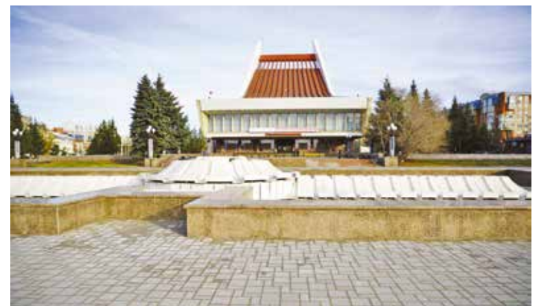
Первый этап реконструкции завершен в октябре 2019 года
