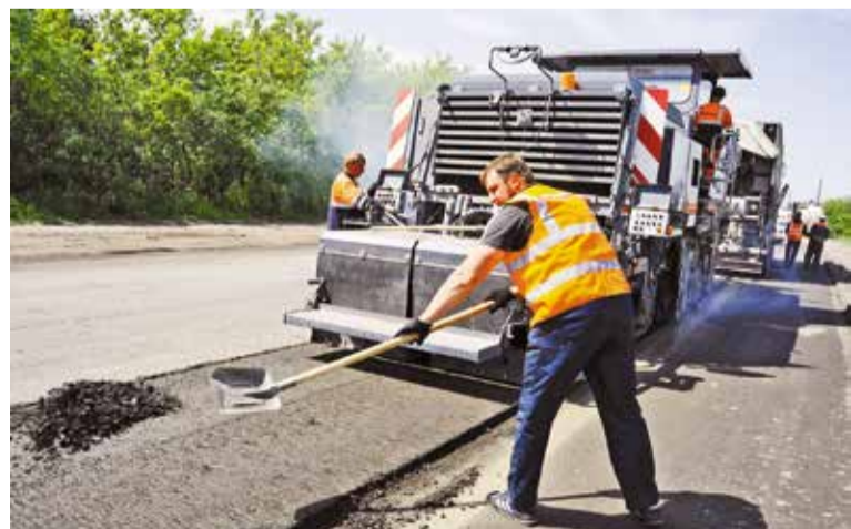
При ремонте используются новые технологии
