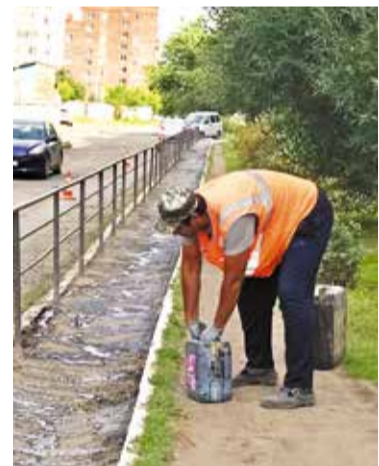
Ремонт тротуара у дома № 129/1 по ул. Звездова
