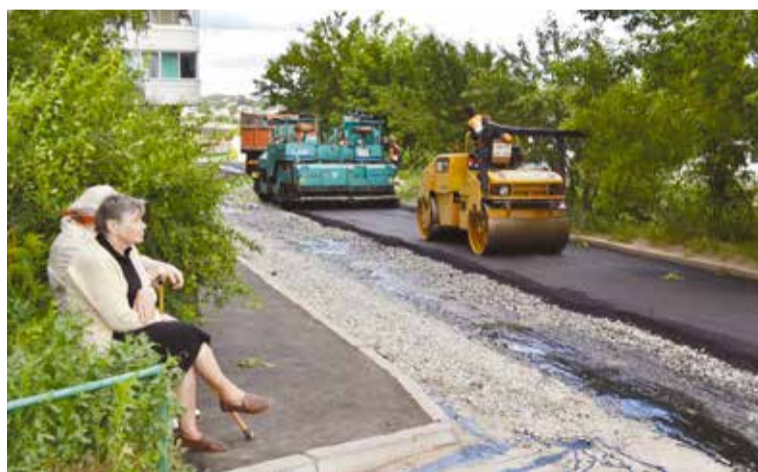
Как и в прошлом году жители будут контролировать ход выполнения работ
