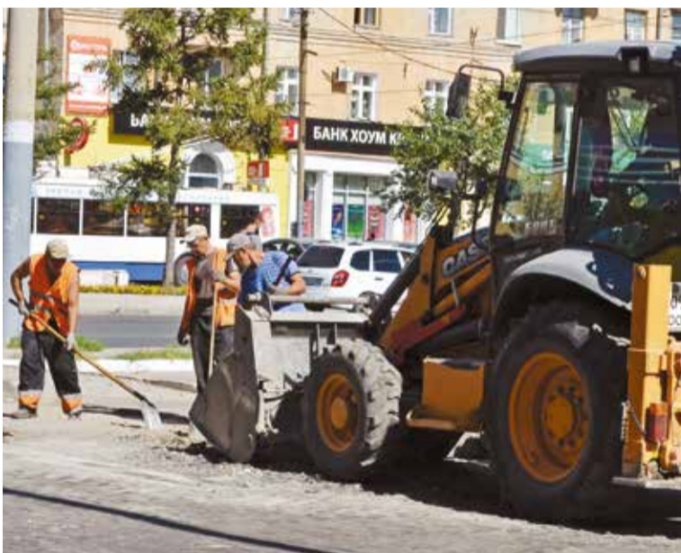
Больше всего дворов отремонтируют в Центральном округе
