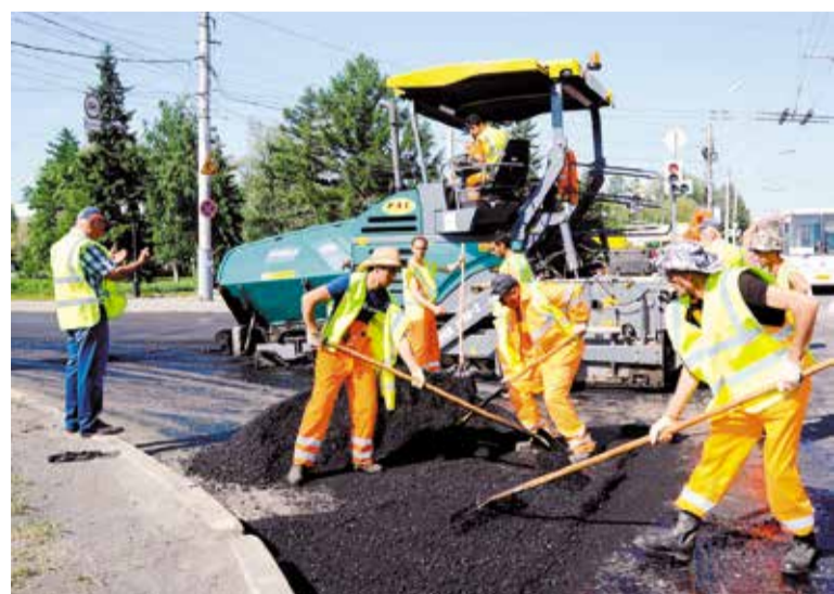
Ремонт городских дорог в Омске завершился 30 сентября
