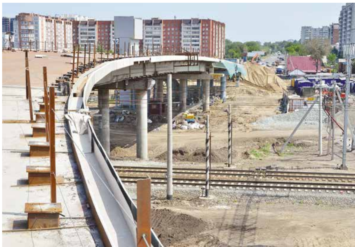
Открытие путепровода на пересечении улиц 15-я Рабочая и Хабаровской намечено на сентябрь 2016 года
