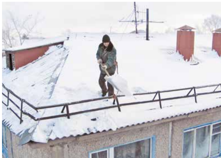
Работники управляющих компаний чистят крыши
