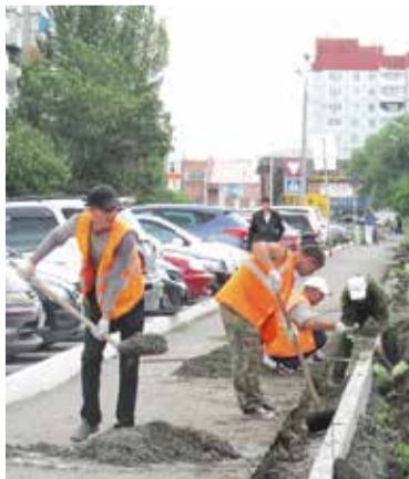
Реконструкция ул. 4-я Линия
