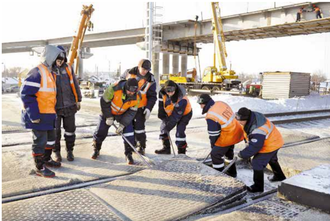
В 2016 году будет сдан в эксплуатацию очередной путепровод – на пересечении улиц 15-я Рабочая и Хабаровская
