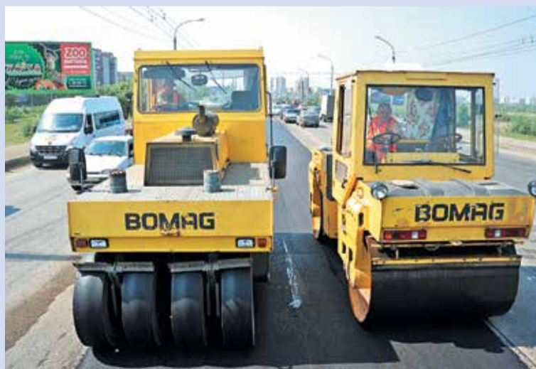
Ремонт дороги на ул. Лукашевича
